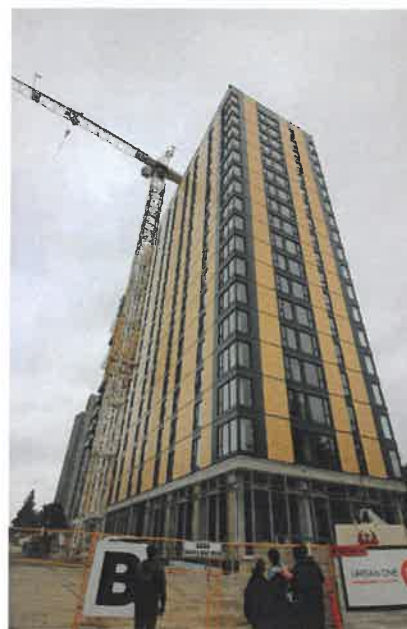
ブロックコモンズ外観 建設中
