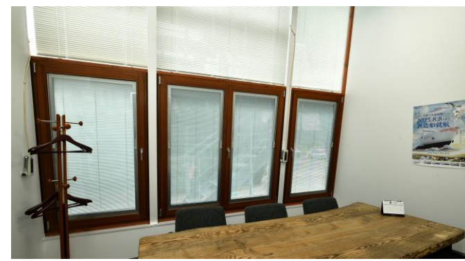
【応接室】ブラインド入りガラス仕様の木製サッシで 遮熱効果が期待できます
