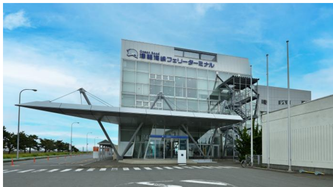
【山側外観】※外構工事はなし
